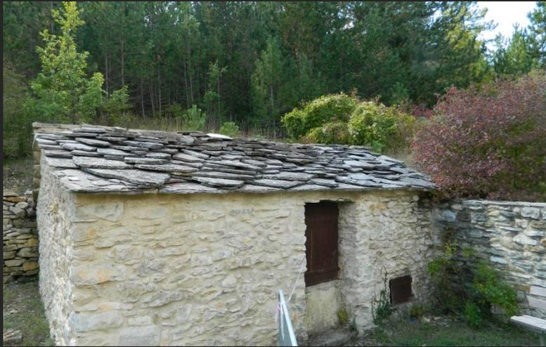
5/ *La toiture de la citerne du lavoir est complètement déstabilisée. Il faut la déposer entièrement après avoir repéré les pierres (photos plus numérotations) et la reposer sur un mortier à la chaux. Ces lauzes proviennent du Revest en Fangat. Elles ont été achetées le 11 novembre 1866 pour la somme de 140 francs transport compris (archives communales).*
