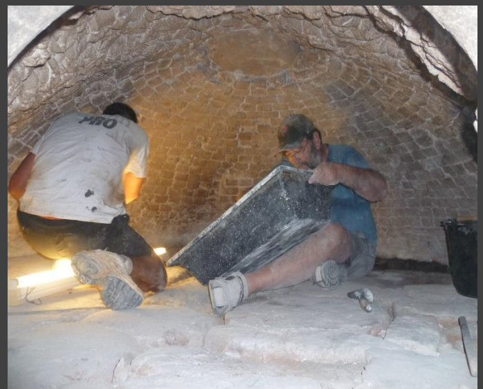
Mise place du ciment réfractaire dans le four.
